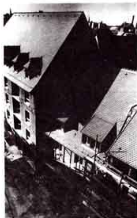
Le chantier HLM de la rue du Renard Prêchant devrait être achevé dans deux mois.
