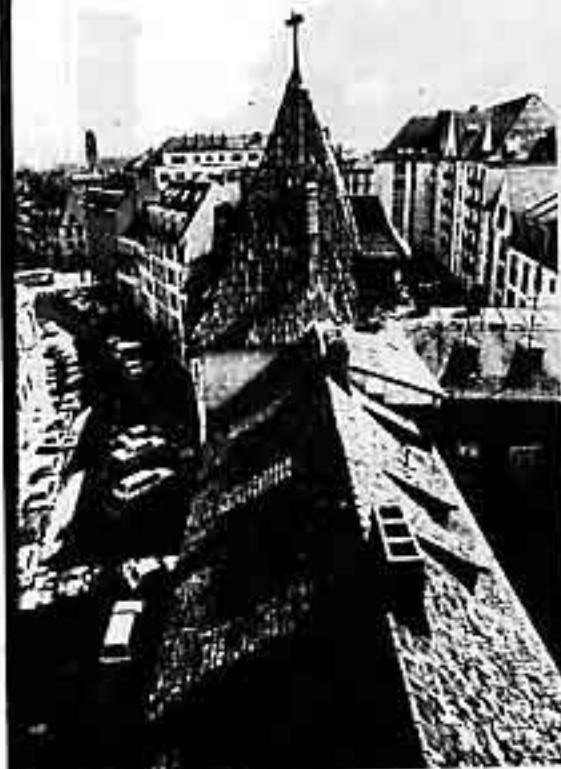
— La place de l'Hôpital et l'immeuble n° 9 sus de la tour de l'Hôpital (photo J. Stadek).
